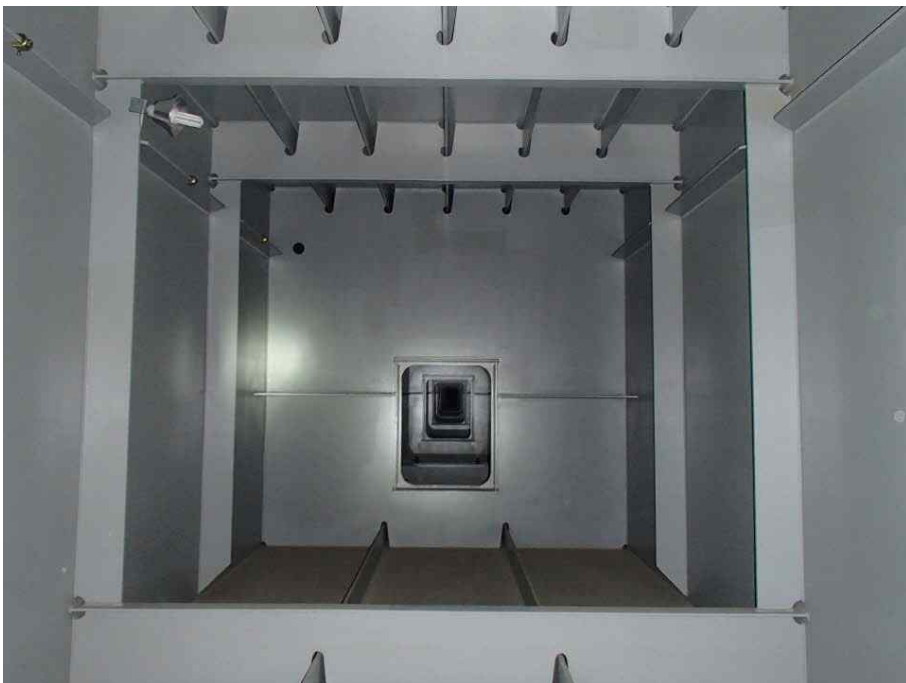
Steel Box Girder 내부 전경
