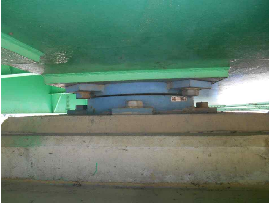
받침장치 전경 (고정단)
