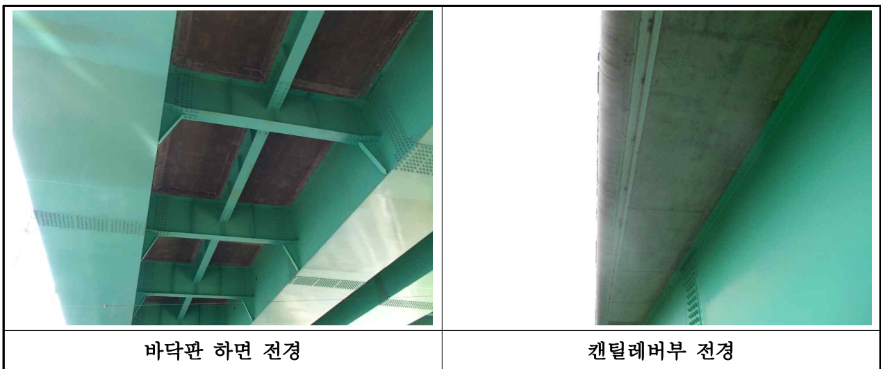
【사진 3.2.1】 바닥판 전경(대구)
