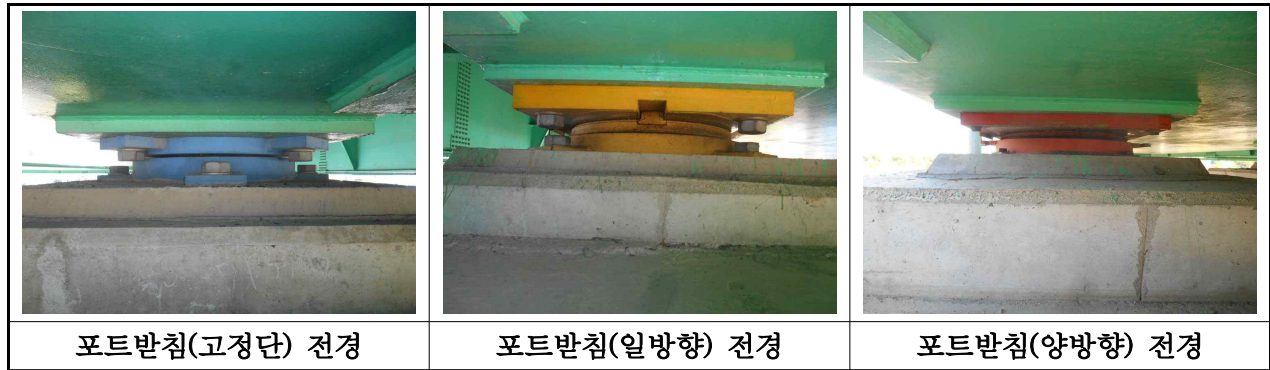
【사진 3.3.12】 교량받침 전경(부산)
