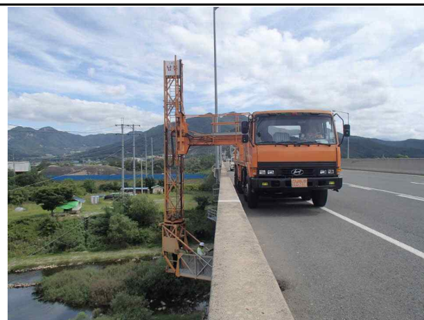
교량점검차를 이용한 조사
