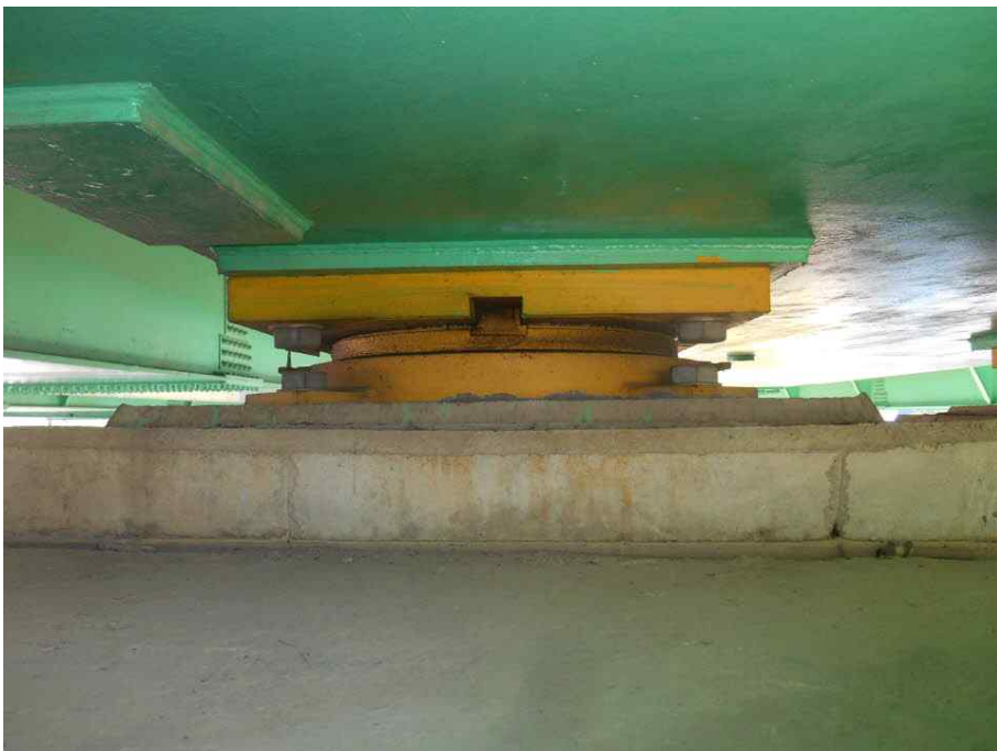
받침장치 전경 (가동단)
