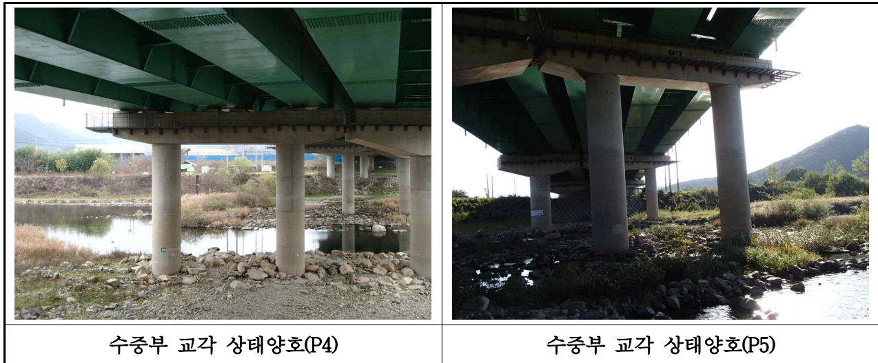
【사진 3.3.11】 교각 수중부 조사 현황(부산)
