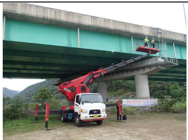
고소점검차를 이용한 조사
