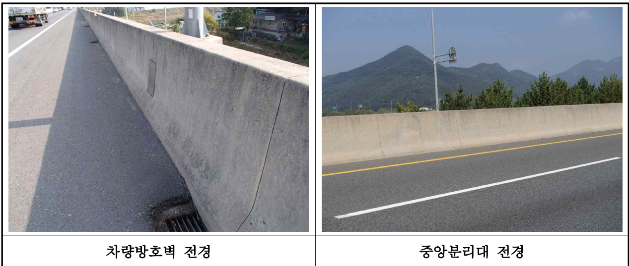
【사진 3.2.21】 방호벽 및 중앙분리대 전경(대구)
