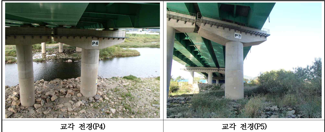
【사진 3.2.9】 교각 전경(대구)
