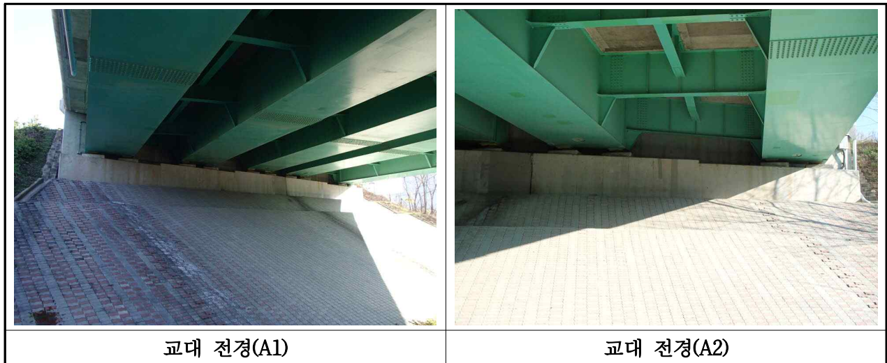
【사진 3.2.7】 교대 전경(대구)
