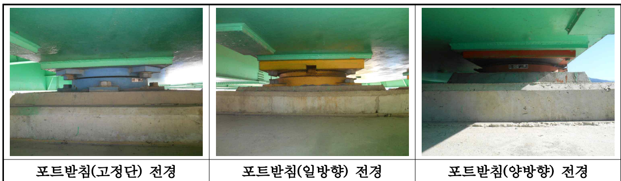
【사진 3.2.12】 교량받침 전경(대구)
