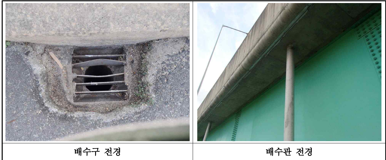
【사진 3.3.19】 배수구 및 배수관 전경(부산)
