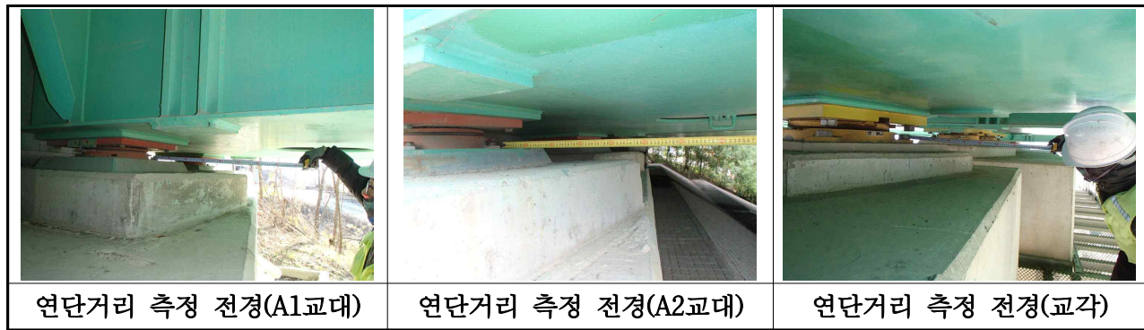
【사진 3.3.14】 연단거리 측정 전경(부산)
