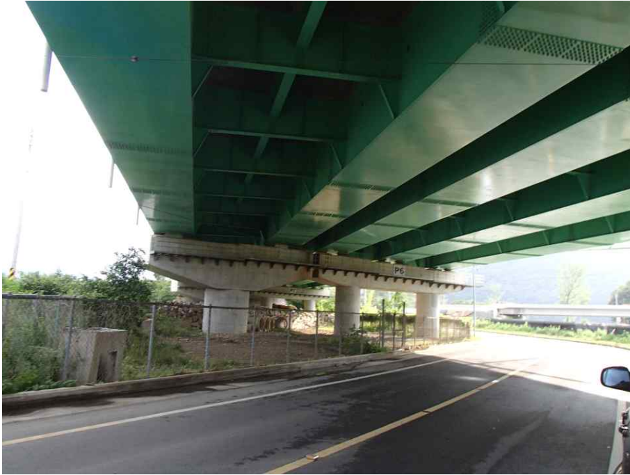
Steel Box Girder 외부 전경
