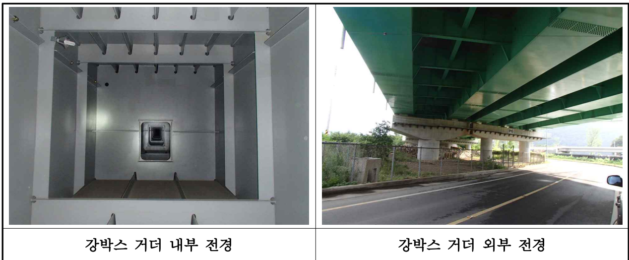
【사진 3.2.3】 강박스 거더 전경(대구)
